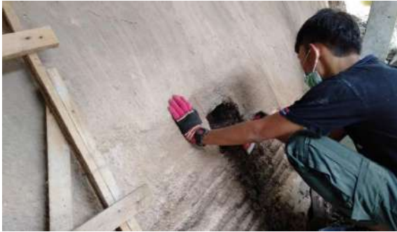
ภาพที่ 18 โครงสร้างช่องเติมเชื้อเพลิงและอากาศผนังข้างเตาเผาไฟต่ำ
