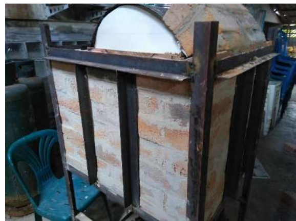
ภาพที่ 12 การใช้โครงเหล็กยึดผนังเตาเผาเพื่อรักษาโครงสร้าง
