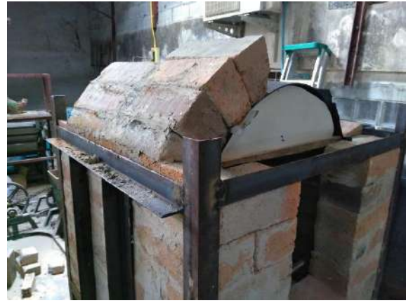
ภาพที่ 11 การใช้อิฐ C2 ชนิดก่อหลังคาเตาเผา
