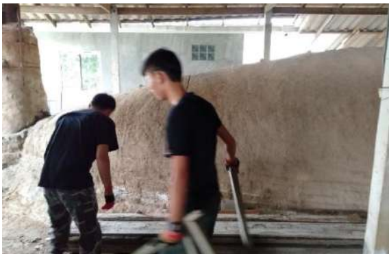
ภาพที่ 19 โครงสร้างผนังข้างและปล่องเตาเผาไฟต่ำ
