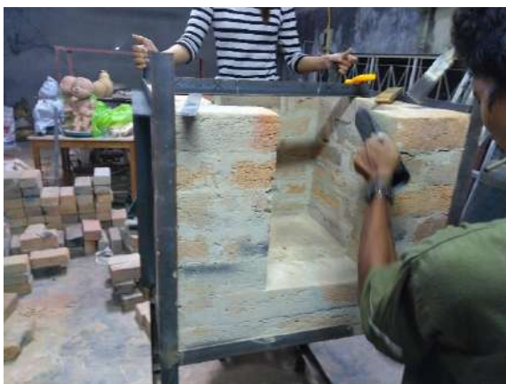
ภาพที่ 10 การใช้อิฐ C2 ชนิดก่อผนังเตาเผา
