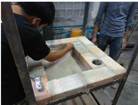
ภาพที่ 9 การใช้อิฐ C2 ชนิดก่อผนังนำมาก่อพื้นเตาเผา
