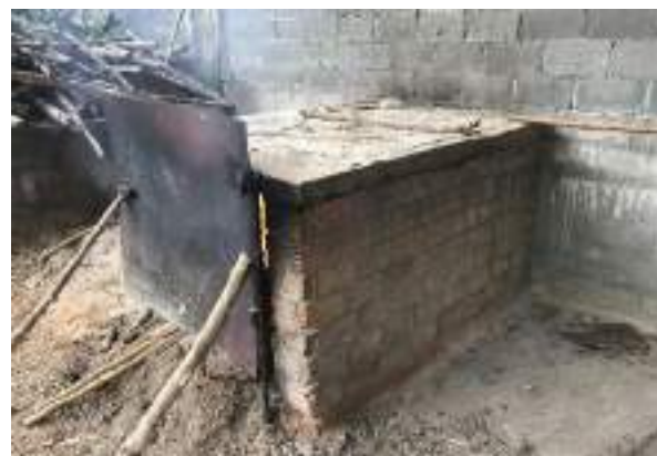
ข. ห้องเชื้อเพลิงเพื่อส่งเข้าห้องรมควัน
